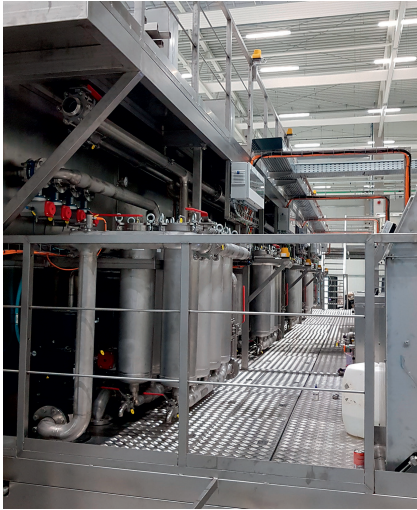
2 Gut über Geländer abgesichert, kann die Anlage auch über das Dach betreten werden © Purima
