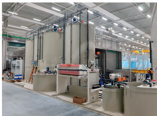
3 Die separate Wasseraufbereitung sorgt für die Einhaltung konstant hoher Reinigungsstandards
